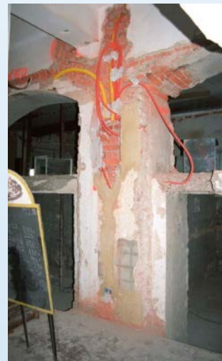
Obsežni utori za novo inštalacijo so nevarno oslabilo konstrukcijo na zelo obremenjenem mestu.
